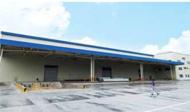
마무리 공사 중인 물류센터 전경
